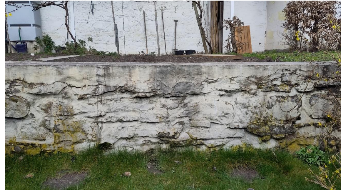
Beispiel einer Terrassenmauer an der Beyenburger Furt
